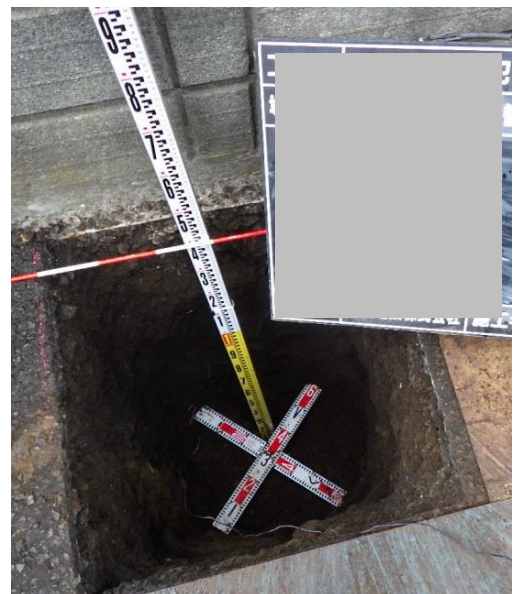
鋼管ポール設置工事の様子
