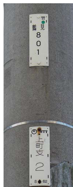
東京電力も使用しているNTT柱
