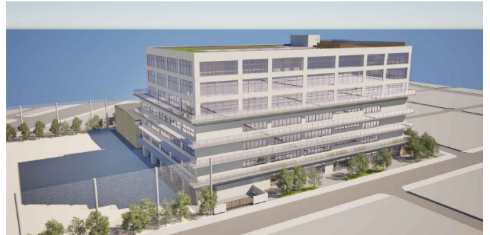
豊岡通りからの外観
