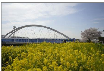
鶴見区市場地区の鶴見川堤防
