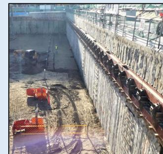
地下1階を設けるために、約8mの深さまで掘削を行いました。山留を支えるためのアースアンカーも施工しました。
