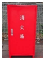
初期消火箱（固定式）
