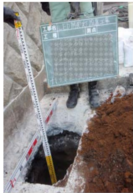
鋼管ポール設置工事の様子
